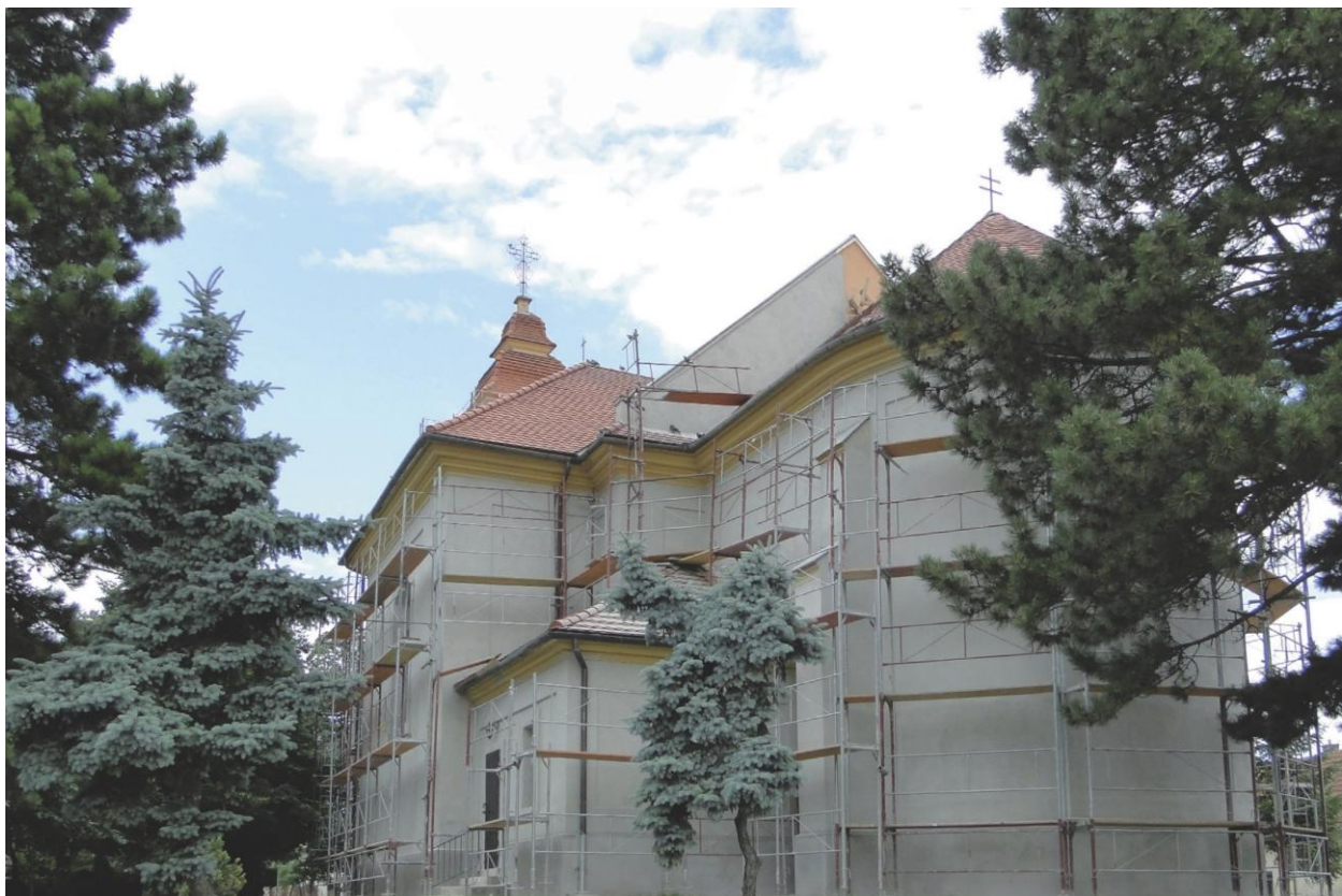
Während der Sanierung mittels NCT.
